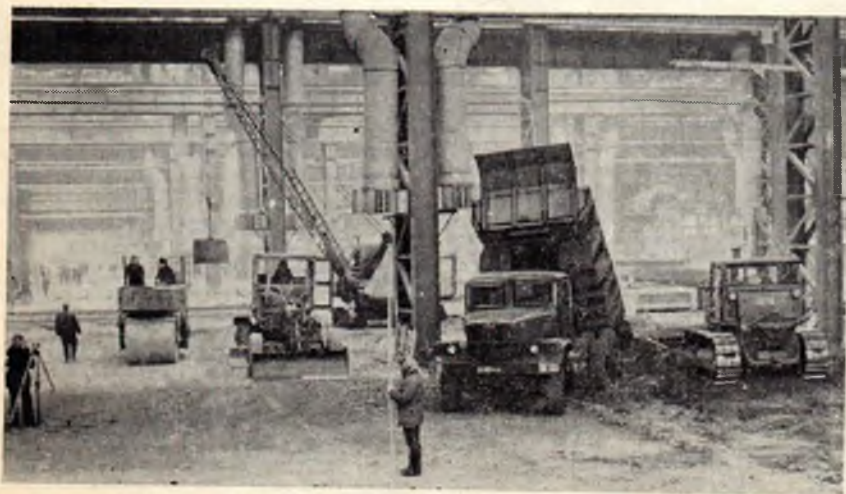
Рис. 1. Экскаваторно-транспортный механизированный комплекс на стройке основания технологических площадей корпусов КамАЗа
