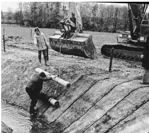
Рис. 49. Укрепление откоса синтетической пленкой
